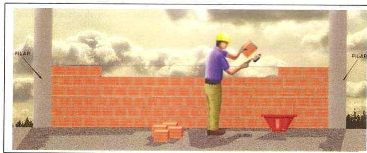
**Figura 51.** Assentamento de Alvenaria 02
